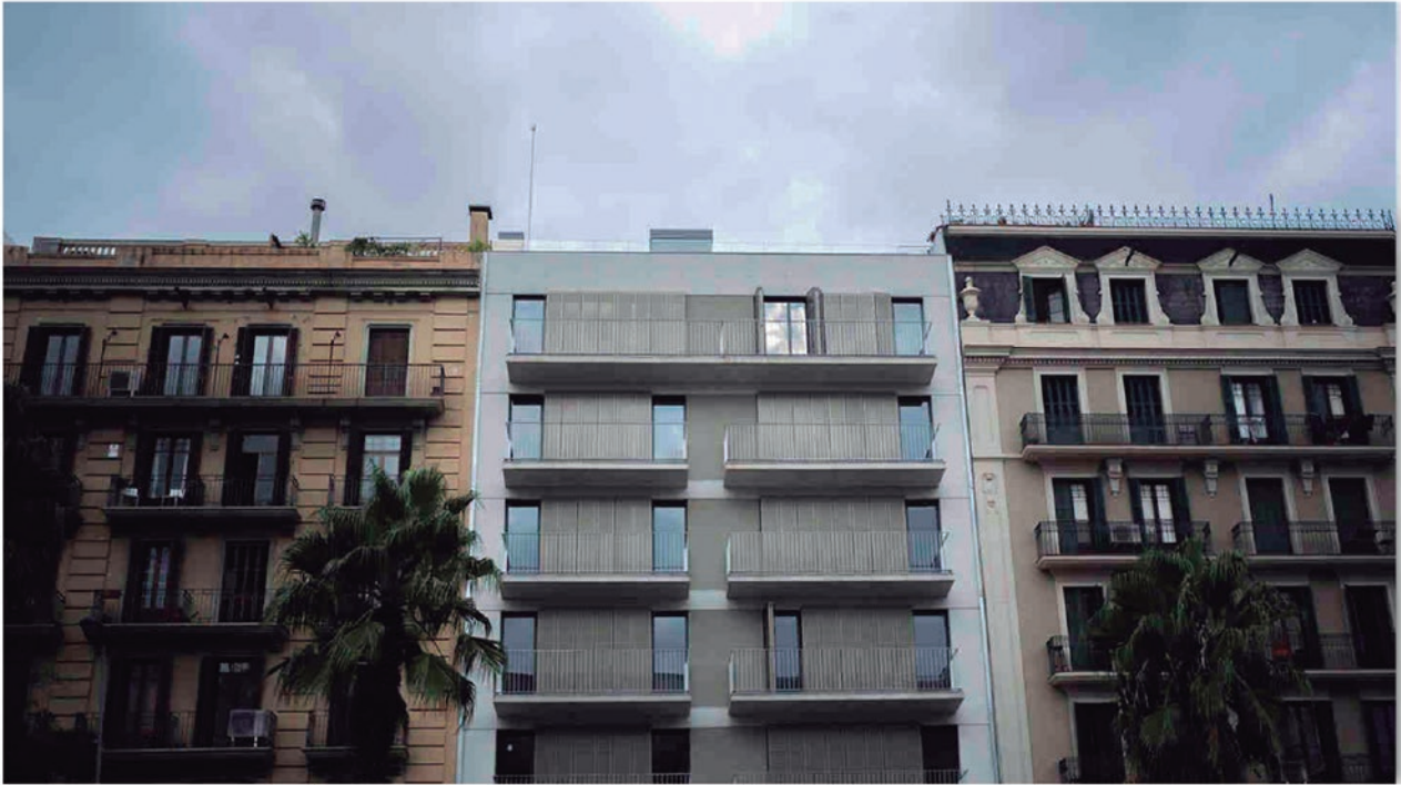
Vista de un edificio en Barcelona. (Joan Mateu Parra)
